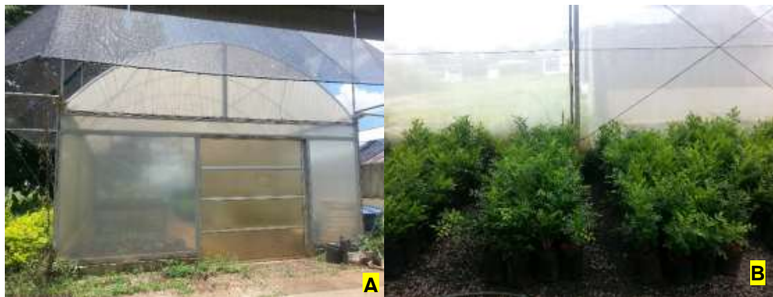
Figura 3. A) Casa de vegetação localizada na parte externa do prédio do Laboratório de Entomologia e Fitopatologia (LEF) e do Laboratório de Quarentena “Costa Lima” (QCL). B) mudas de murta de cheiro para realização da poda. Foto: Camila Souza
